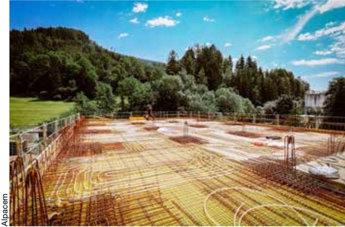
Die thermische Bauteilaktivierung nutzt die Speichermasse des Betons, um ein Gebäude mit einem geringen Energieeinsatz zu heizen und zu kühlen.
